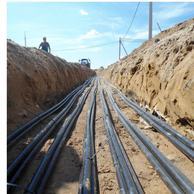
Прокладка кабеля вне здания
